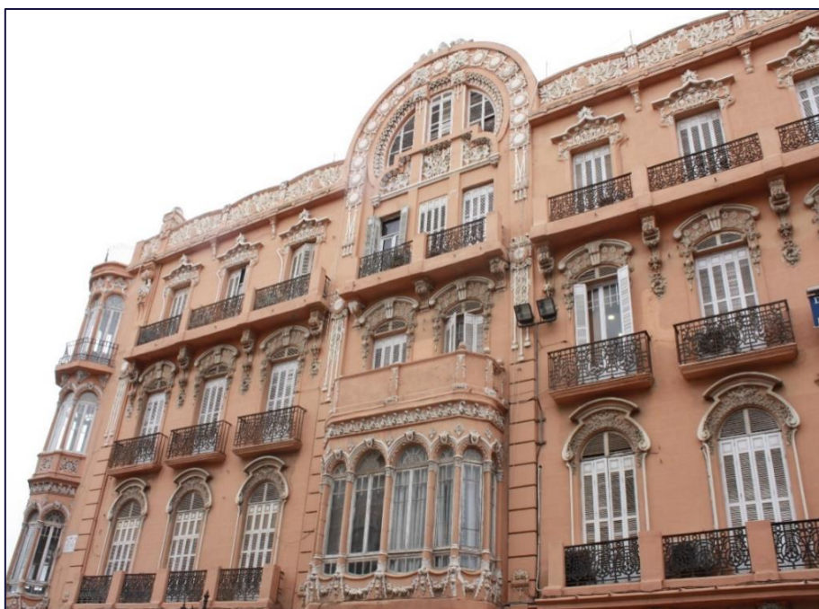
FACHADA DEL EDIFICIO MELUL
